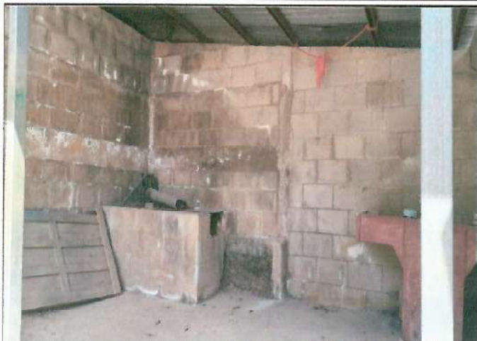
Foto1: REPARACIÓN DE REPELLO Y CERNIDO DE PARED
