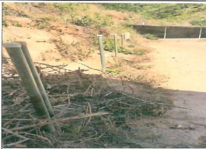
Foto 2: CERCO MURO PERIMETRAL
