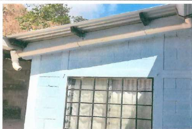
Foto 4: CANALES Y BAJADAS DE AGUA PLUVIAL
