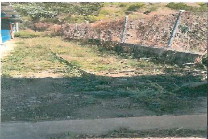
Foto 3: LOSA DE PATIO
